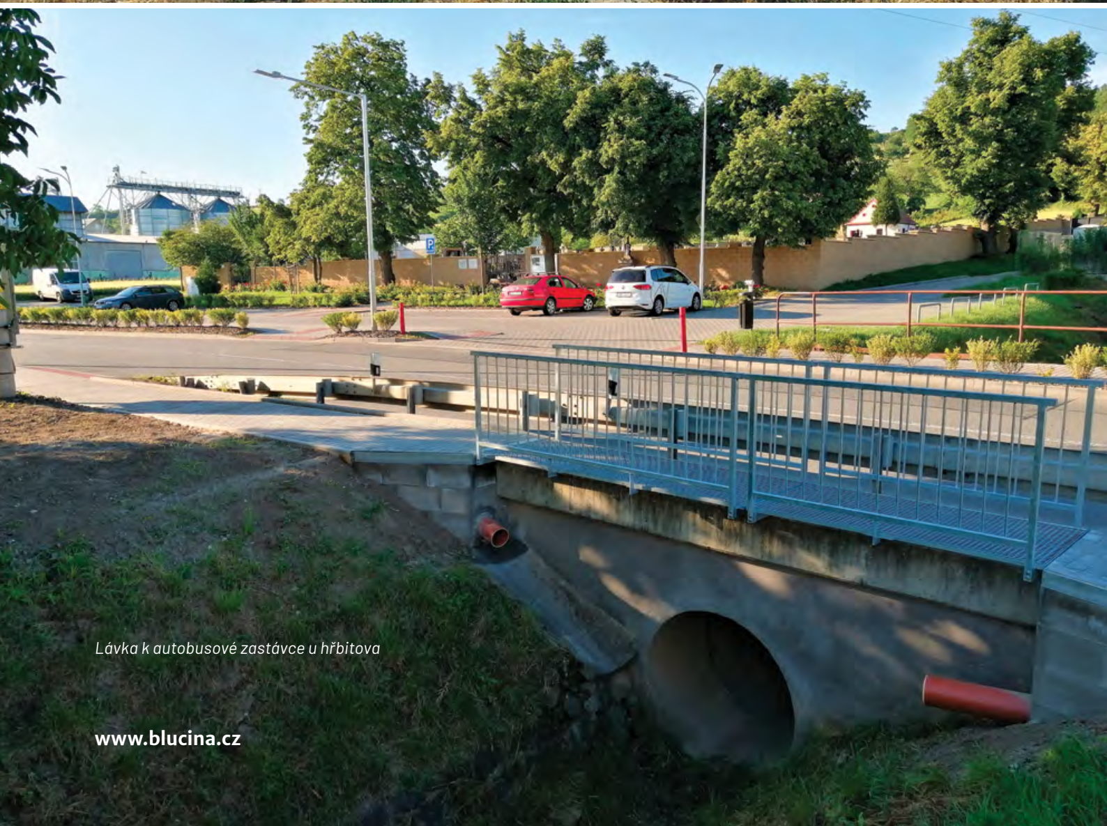
Lávka přes Litavu u ulice Na Čezavě
