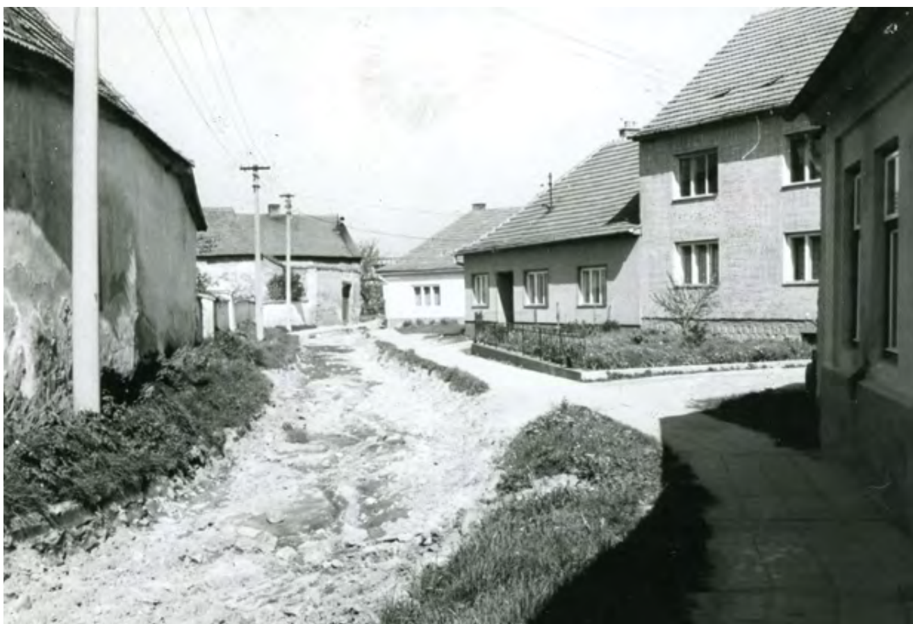
Pohled na ulici Na Lázních – 4. 5. 1980.
