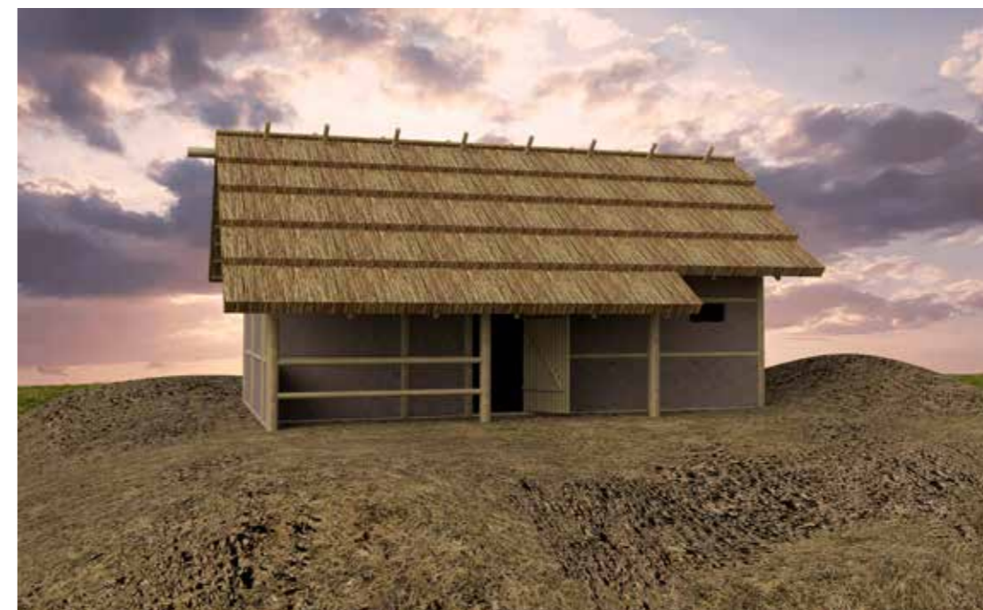
Stavby kůlové konstrukce s proplétanými stěnami s hliněnou omazávkou. Funkce řemeslných dílen - kovolictví, keramika, proutěná a textilní řemesla.
